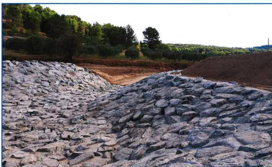
Une première couche de remblai a été effectuée sur laquelle la digue viendra prendre appui; elle prend forme rive gauche, le remblai étant achevé. La déviation du chemin goudronné est désormais réalisée en concassé; un revêtement bicouche sera ensuite posé.
