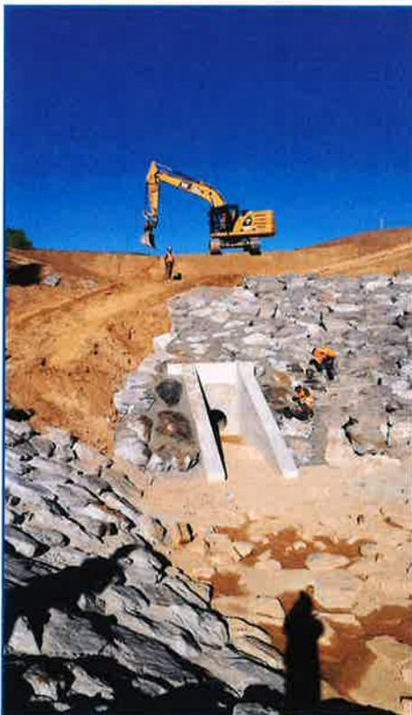
Les travaux de remblayage sont aujourd'hui presque achevés et la digue est maintenant à la hauteur voulue (hauteur maximale par rapport au fond du talweg de 9 à 10 m). Le façonnement de l'ouvrage se poursuit. L'évacuateur de crues est en cours d'installation et la poutre de déversement sera bientôt réalisée. Les enrochements du
