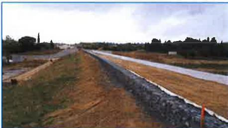
La digue est désormais fermée avec du remblai étanche sur le bajoyer (paroi verticale) rive gauche. Le planning prévoit la fermeture en remblai compacté et étanche sur le bajoyer rive droite pour le deux novembre. La fin de la construction du dispositif en touches de piano (PK Weir) sera réalisée également pour le 2 novembre. La rehausse de la crête sera achevée avec la pose des gabions (bordures). Divers travaux d'enrochement seront aussi entrepris en aval de l'ouvrage.
