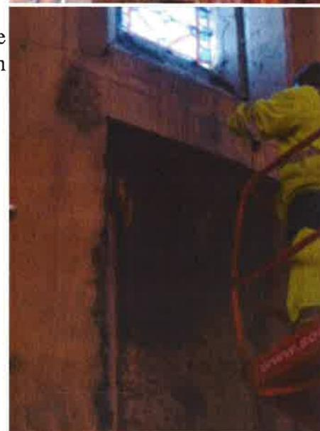
Dans l'immédiat l'**ARCHITECTE** propose au **MAÎTRE D'OUVRAGE** de poser un filet de protection chevillé dans les maçonneries de pierres sur l'allège de la baie de la travée 2, et de condamner les espaces jouxtant les élévations Sud et ce sur une largeur de 3 mètres environ pour éviter tout accident sur les personnes.
