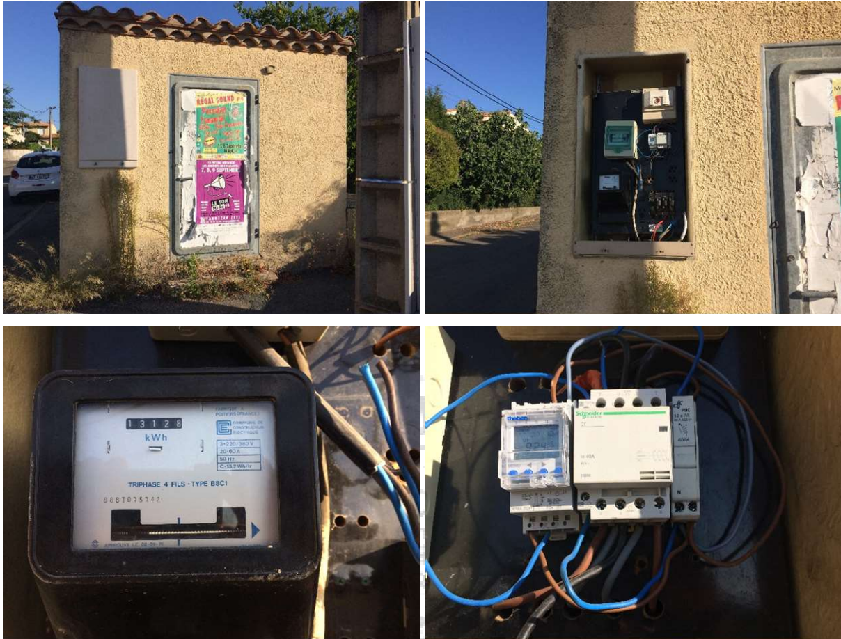
Ci-dessous : photos de l'armoire « Poste 5 »
